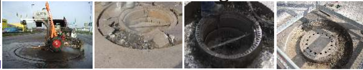
Schachtsanierung DS 1400/2000 Rundsneider zum Kanalschachtausbau
