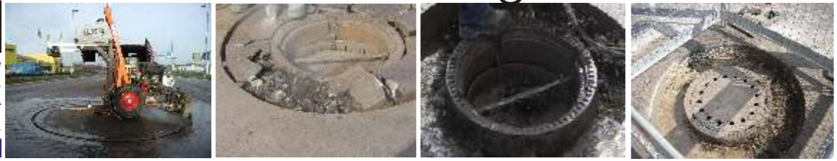
Schachtsanierung DS 1400/2000 Rundsneider zum Kanalschachtausbau Ausbau mit Hydraulikhammer Direktanschluß an LKW Verdichten mit Hydraulikhammer Direktanschluß LKW Fertig ausgebauter Kanalschacht
